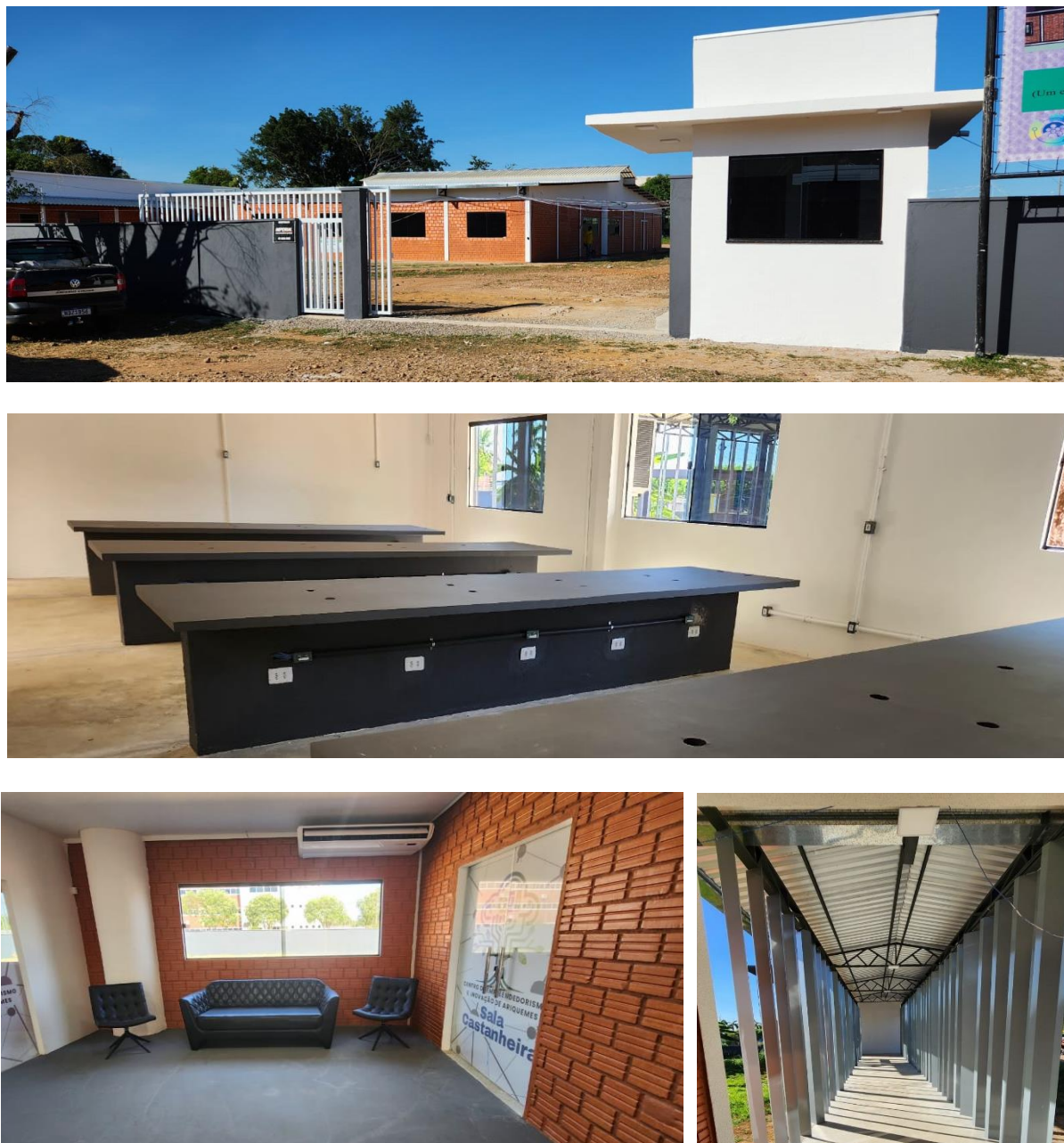
Figura 15 — O prédio reformado para instalação do Centro: vista de fora para dentro, espaço do Laboratório de Informática, ambiente de Coworking e corredor de acesso a banheiros
