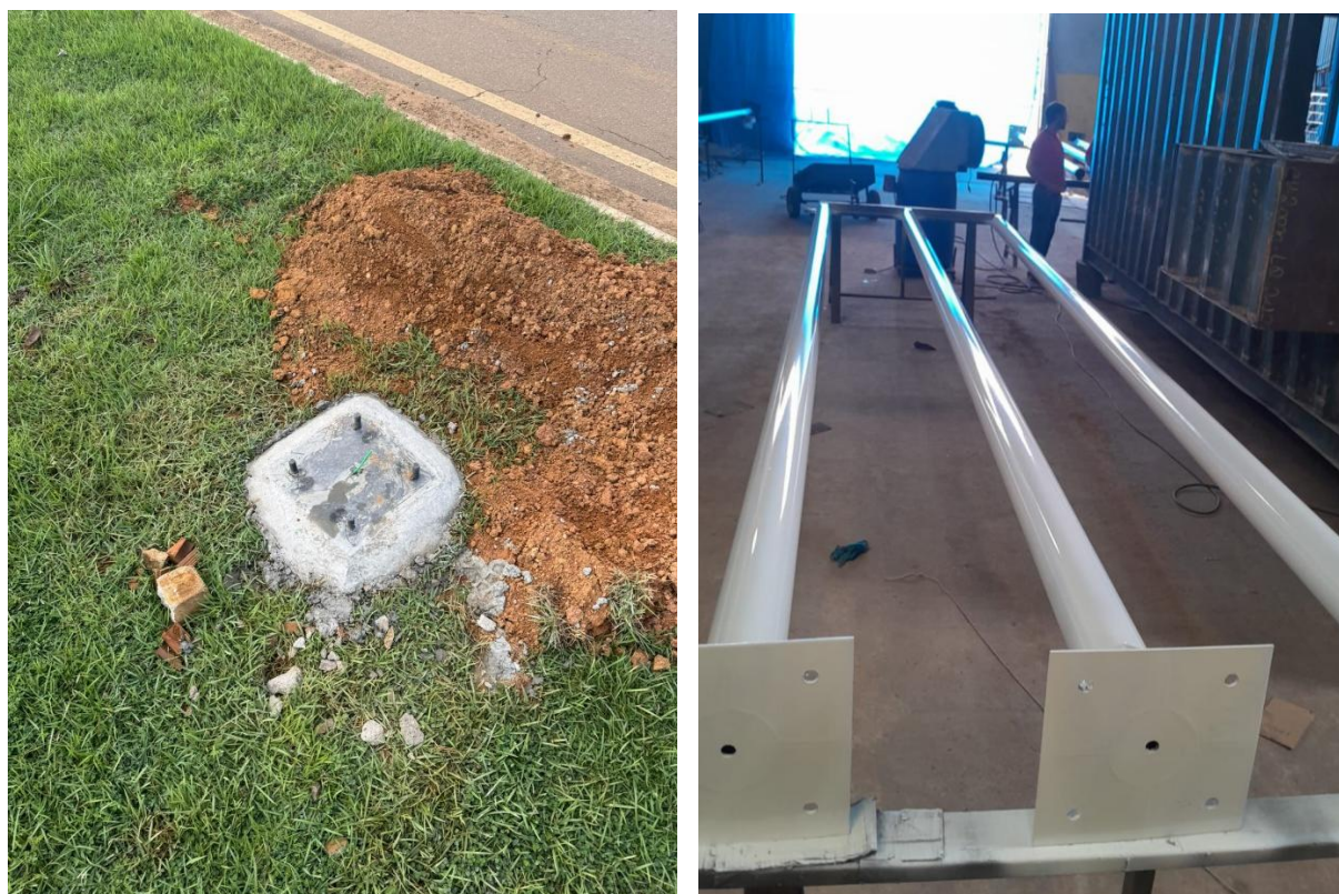
Figura 19 — Preparações para o posteamento das câmeras
