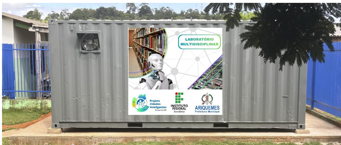
Figura 3 — Contêiner para a instalação dos Laboratórios Multidisciplinares
