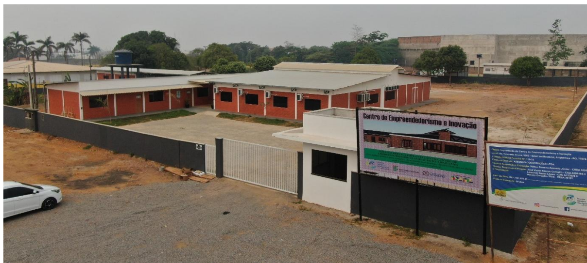
Figura 20 — Centro implantado: vista de fora para dentro e de ambientes internos
